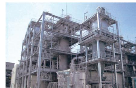
流動床式焼却炉の排煙処理設備
