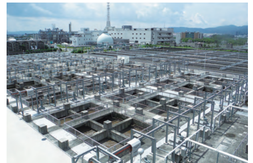
高度処理施設（鳥羽水環境保全センター）
