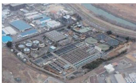
⑥ 伏見水環境保全センター
