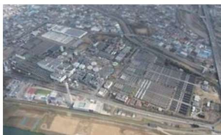
④ 鳥羽水環境保全センター
