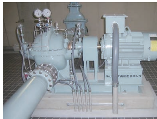
インバータ制御方式のポンプ
