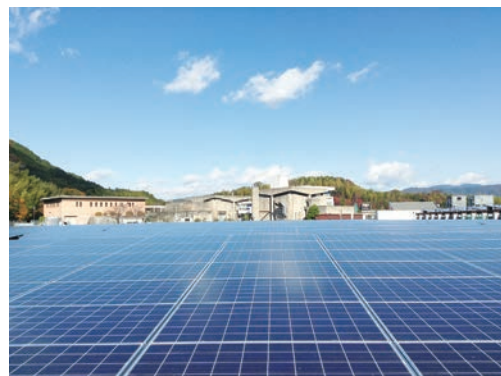
太陽光発電設備（新山科浄水場）
