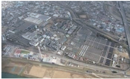
4 鳥羽水環境保全センター
