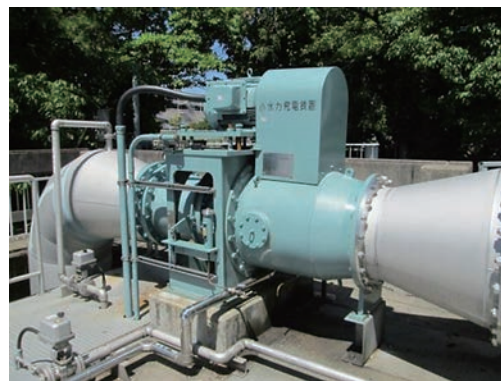
小水力発電設備（石田水環境保全センター） 定格出力：9 kW 発電実績：80,500 kWh（平成 30 年度）
