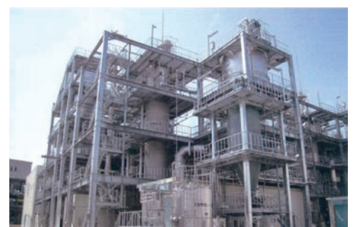
流動床式焼却炉の排煙処理設備
