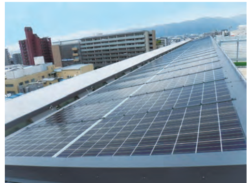
太陽光発電設備(太秦庁舎)
