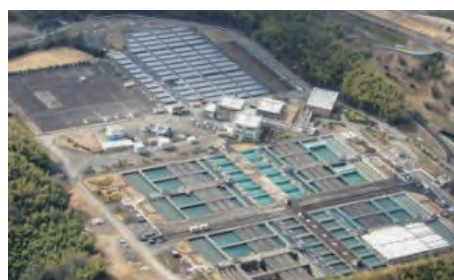
③ 新山科浄水場
