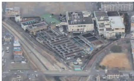
5 鳥羽水環境保全センター 吉祥院支所
