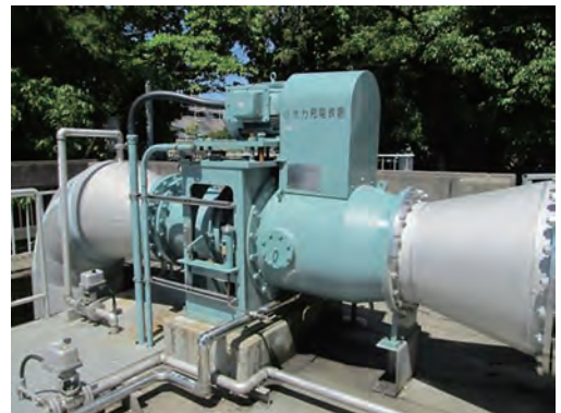
小水力発電設備(石田水環境保全センター) 定格出力：9 kW 発電実績：79,890 kWh(平成 29 年度)
