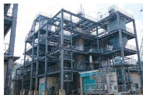
污泥焼却炉の排煙処理設備
