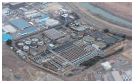
6 伏見水環境保全センター
