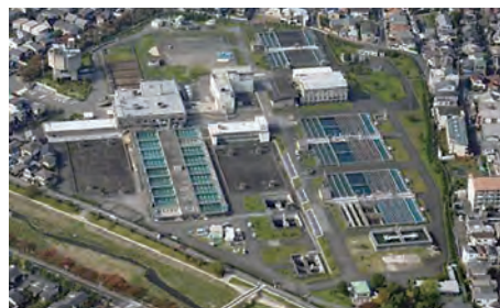
② 松ヶ崎浄水場
