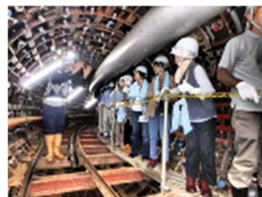
施工中の雨水幹線の内部(施設見学会)
