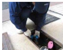
水道開閉栓作業
