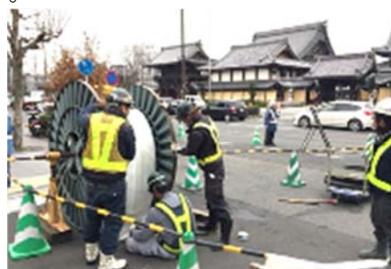
下水道管更生の施工状況
