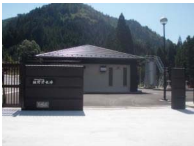
再整備後の細野浄水場（旧京北地域水道）
