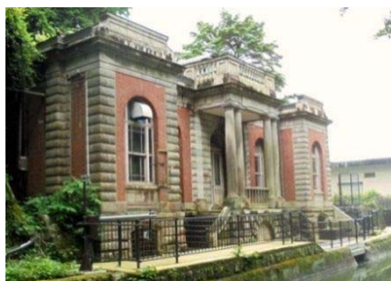
旧御所水道ポンプ室
