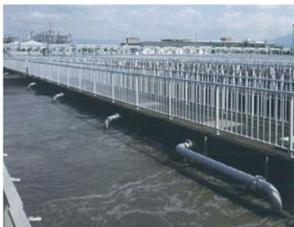
下水道の水処理技術の調査研究
