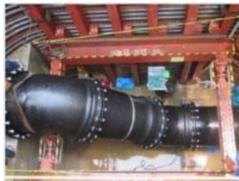
水道配水管更新工事
