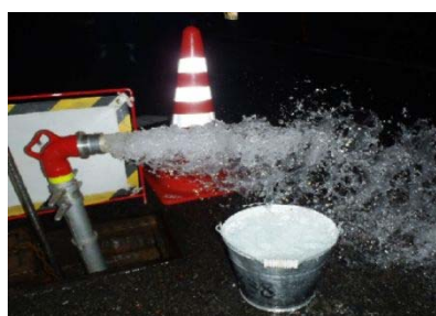
「京（みやこ）の水道管おそうじプロジェクト」における水道管洗浄作業の様子
