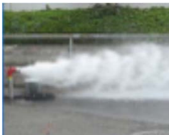
消火栓放水研修
