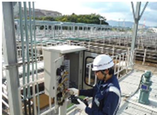
処理設備の点検状況
