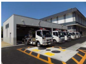
北部エリアを所管する太秦庁舎
