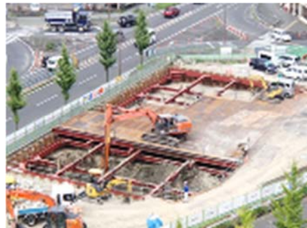
雨水調整池の施工状況
