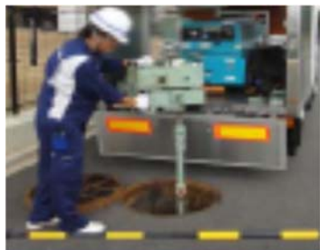
幹線配水管充水研修
