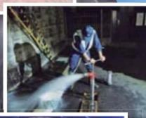
下水道管更生工事 (古い管の内側に新しい管をつくる)
