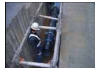
老朽化した水道管の更新
