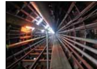
整備中の雨水幹線(新川6号幹線)
