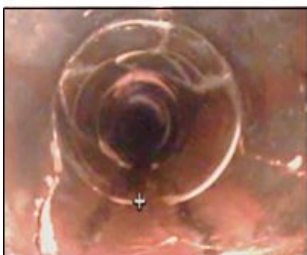
老朽管（施工前）
