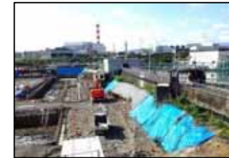
水環境保全センター施設の改築工事
