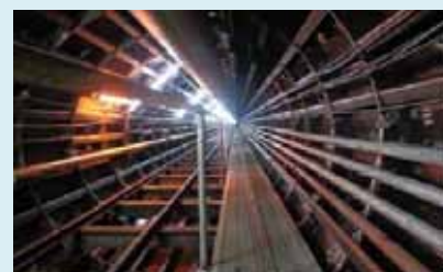
整備中の雨水幹線の内部（新川 6 号幹線）
