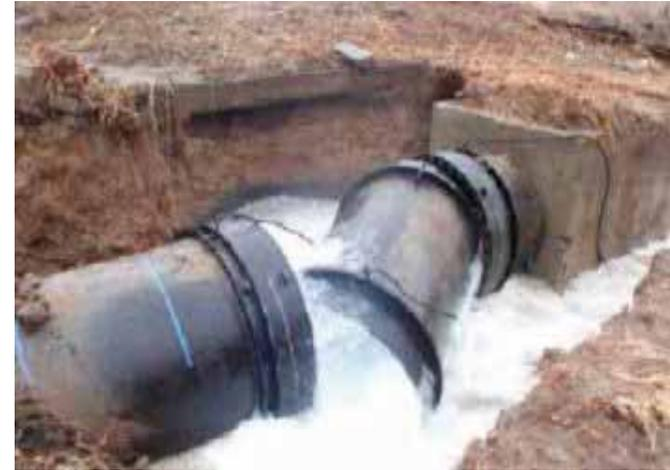
東日本大震災による水道管の継ぎ手離脱
