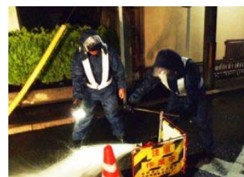
漏水等に伴いにごり水が発生した場合の洗管作業の様子
