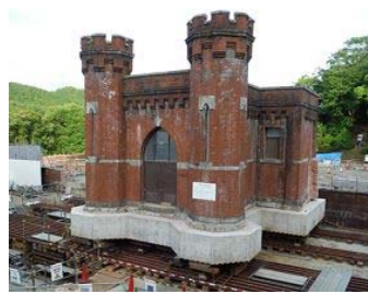
蹴上浄水場第 1 高区配水池 （外観を保存する工法による改築更新の様子）
