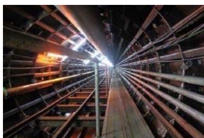
雨水幹線（施工中）の内部の様子
