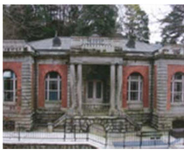
旧御所水道ポンプ室
