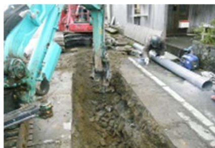
下水道管布設替えの施工状況
