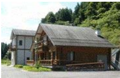
京北浄化センター
