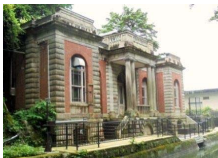
旧御所水道ポンプ室
