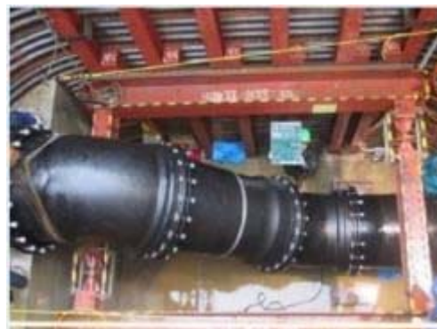
水道配水管更新工事
