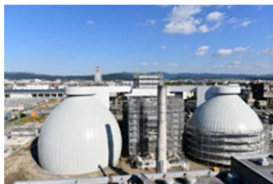
汚泥消化タンクの再整備
