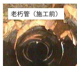
既設下水道管を使用した更生（長寿命化） （古くなった管の内側に新しい管となる素材を入れる）
