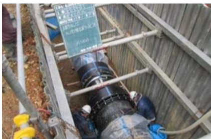
配水管の更新（耐震化）の様子
