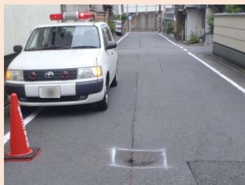
下水道管の破損による道路陥没
