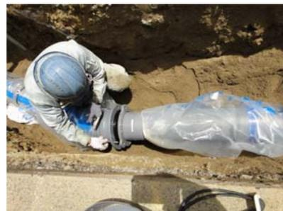
100年管を使用した水道管の布設替え
