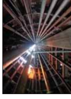
整備中の雨水幹線(新川6号幹線)
