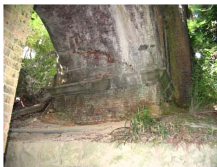
西側橋脚部ひび割れ
