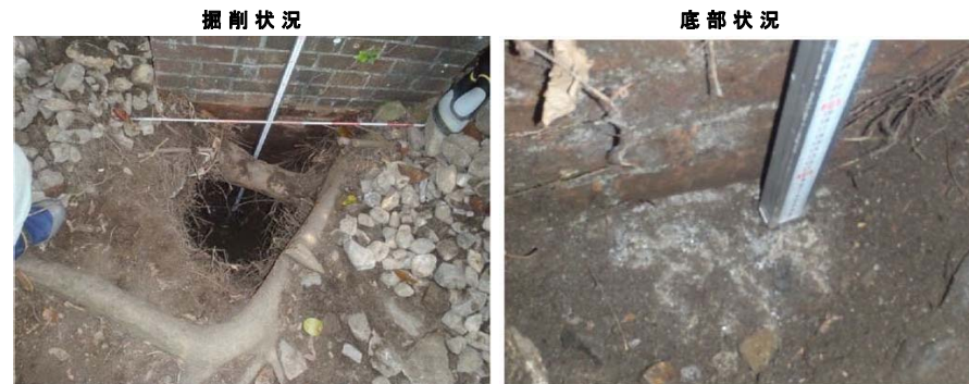
煉瓦造に密着したコンクリート構造物
