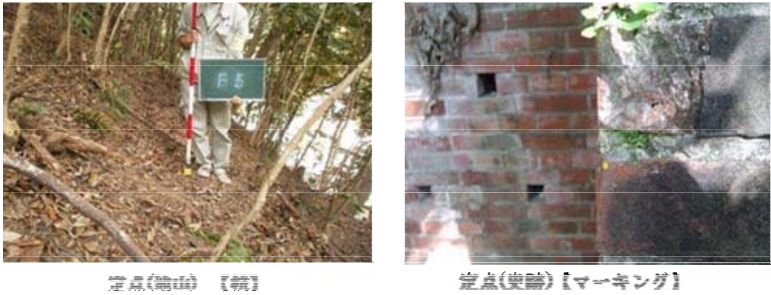
図-2 定点設置状況
