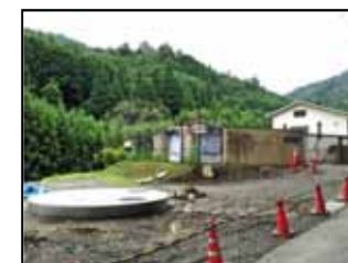
中川浄水場(整備中)
