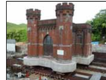
第1高区配水池(蹴上浄水場)の更新
