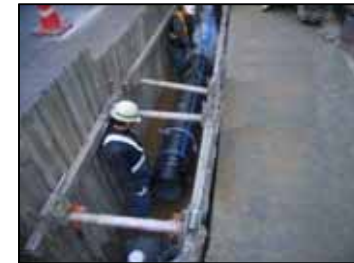
老朽化した水道管の更新
