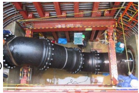
水道配水管工事
