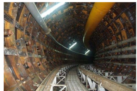
山科三条雨水幹線（山科駅周辺地区）
