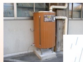
雨水をためて利用する
