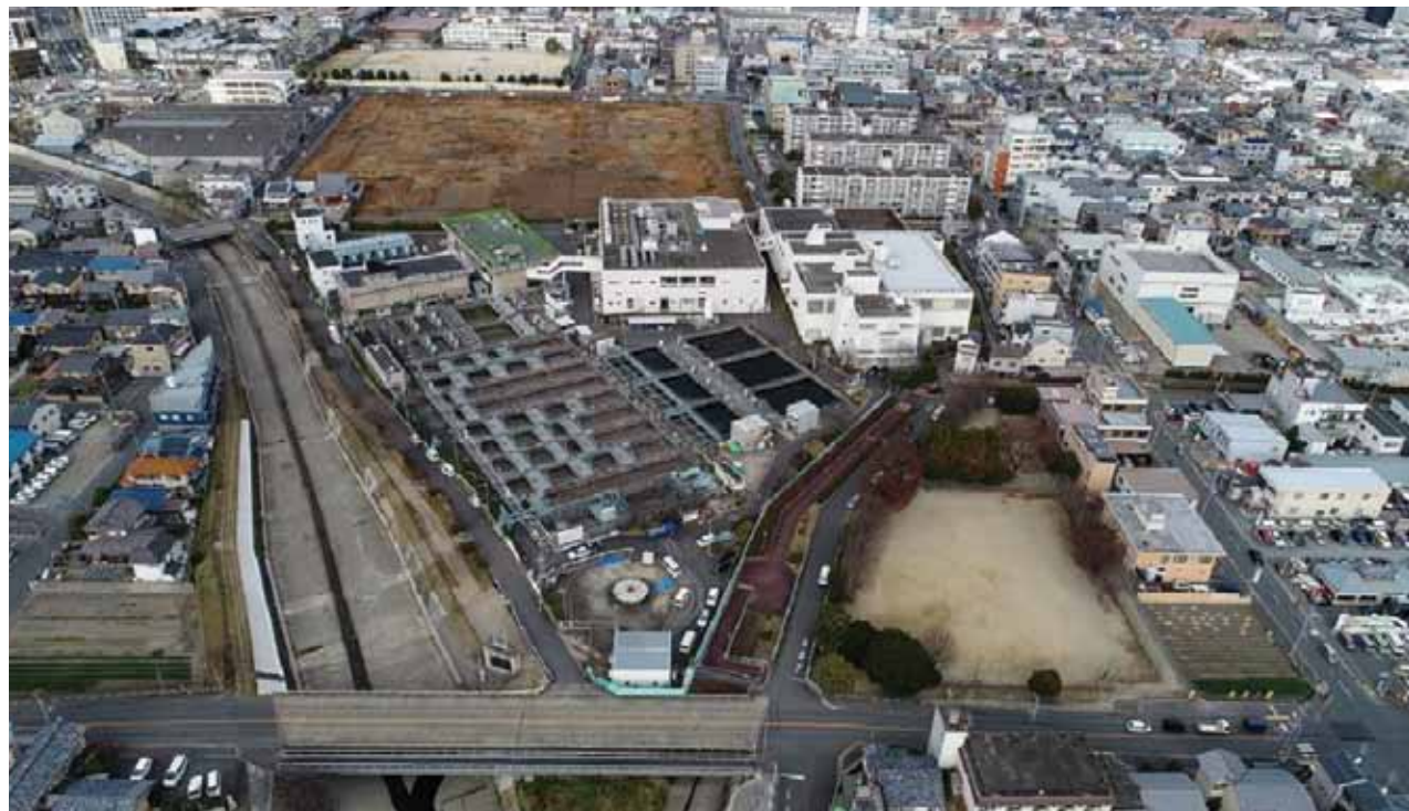
吉祥院支所全景
