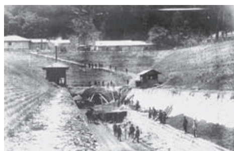
建設当時の様子
