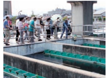
▲松ヶ崎浄水場
