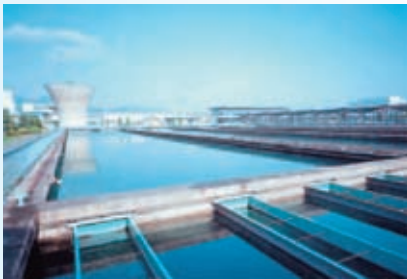
山ノ内浄水場
