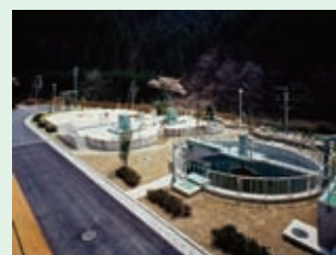
京北浄化センター
