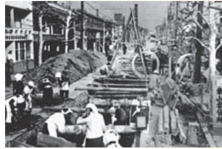
管布設工事（川端二条東入ル）
