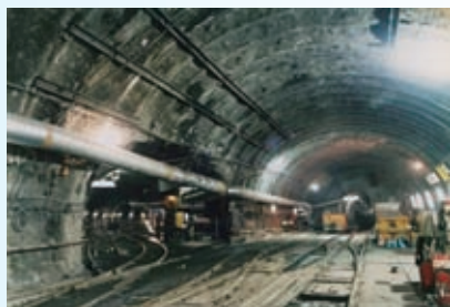
第2疏水連絡 トンネル
