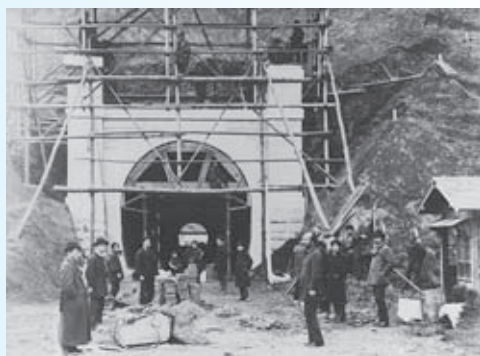
第1 疏水第2トンネル東口洞門工事
