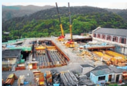
蹴上浄水場低区配水池改良
