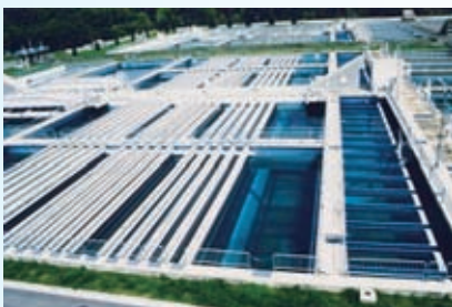
新山科浄水場
