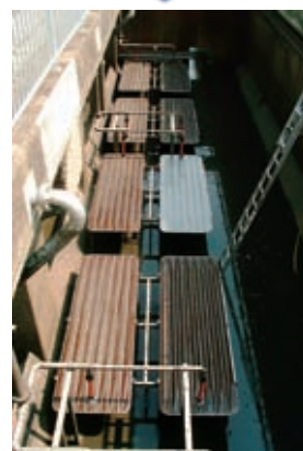
省エネルギー機器への更新 (超微細気泡散気装置 ・水環境保全センター)
