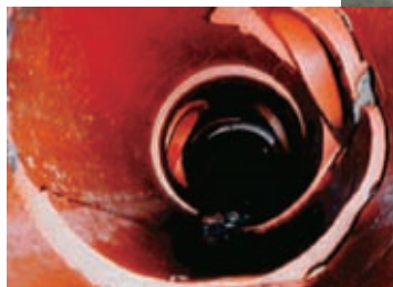
改築更新が必要な 老朽下水管路
