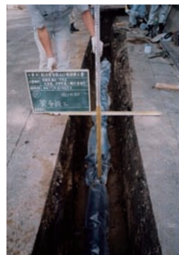
水道耐震管の布設
