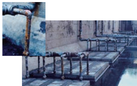
改築更新が必要な老朽施設 (散気装置・水環境保全センター)
