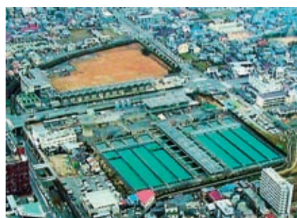
山ノ内浄水場
