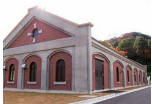
レンガ調の採用により景観に配慮した 蹴上浄水場の施設
