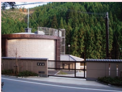
鞍馬・貴船簡易水道*浄水場
