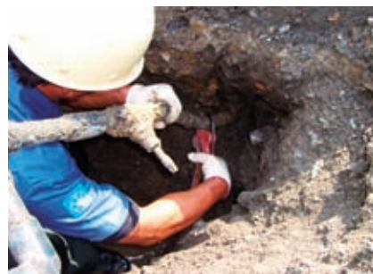
鉛製給水管取替工事
