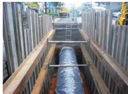
水道耐震管の布設
