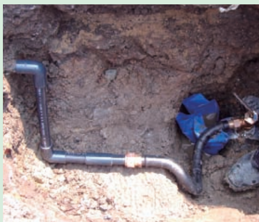
耐衝撃性硬質塩化ビニル管への取替工事を行った給水管
