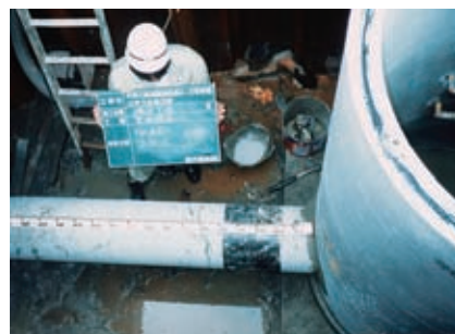
下水管耐震用可とう継ぎ手
