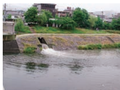
雨水吐口から河川への下水放流
