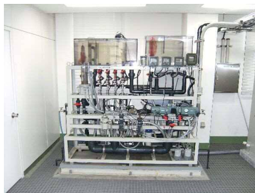
図4-3 原水水質自動監視装置
