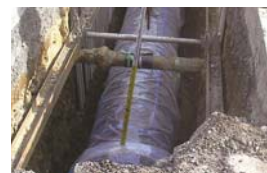
▲配水管耐震化工事
