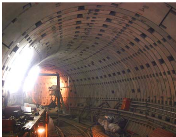
雨水幹線の整備工事
