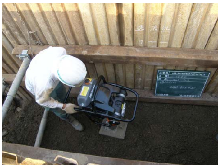
下水道管布設工事（埋戻し）
