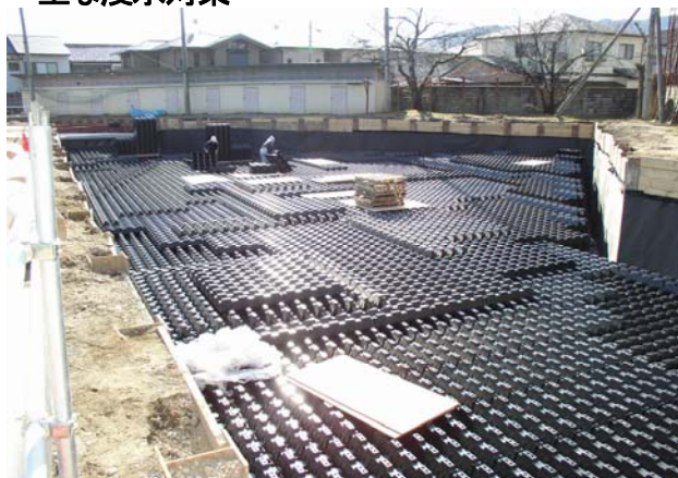
雨水調整池の整備工事
