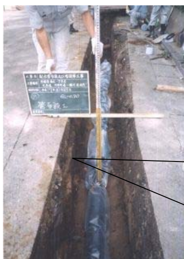
水道管路の布設替（耐震化）工事
