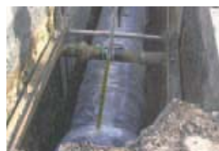
▲配水管耐震化工事
