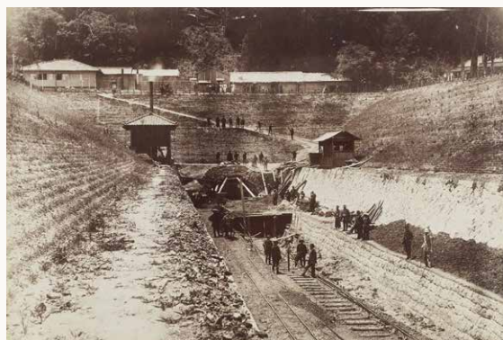
第1トンネル東口工事（明治19年）
