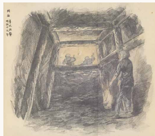
長等山隧道 導坑掘鑿(明治19年) ダイナマイトを仕掛ける穴は、画のようにノミと金槌であけました。 一時ボーリング機械を用いましたが、使いにくいということで、結局最後まで人力で進めました。
