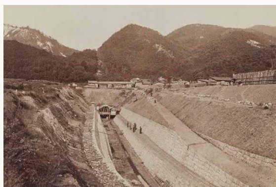
第1トンネル西口工事（明治21年頃）
