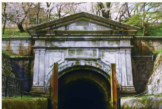
現在の第1トンネル東口
