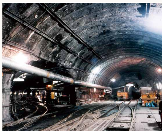
連絡トンネル建設時の様子
