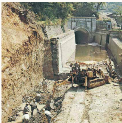
改修時の様子(昭和の大改修)
