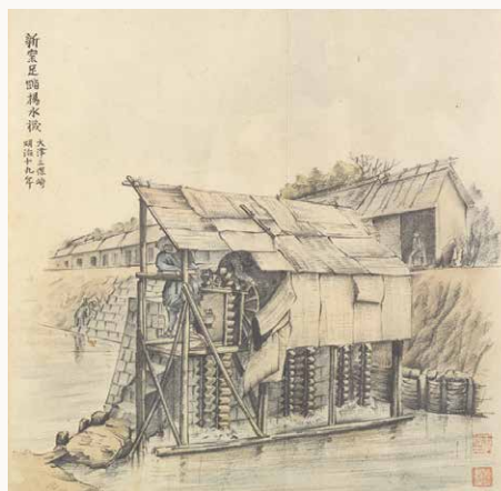
新案足踏揚水機 大津三保ヶ崎(明治19年) 後方の地面の高さからみて、大津の取入口付近と考えられます。 豎坑やトンネル排水も含めて、工事初期はポンプを用いず人力に頼りました。
