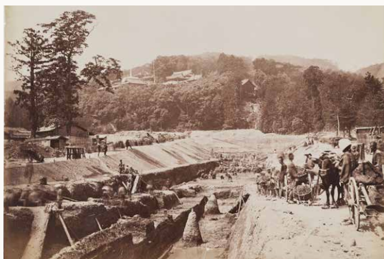
大津運河と大津閘門の掘削工事（明治19年）
