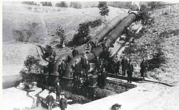
第1期蹴上発電所への送水鉄管(明治24年)〔田邊家資料〕
