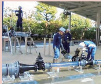
体験型研修施設(水道技術研修施設)
