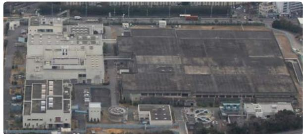
昭和56年に運転開始。住宅地に隣接した施設であるため、半地下密閉構造とすることで、周辺環境に配慮しています。また、大規模太陽光発電や、下水処理過程での放流落差を利用した小水力発電など再生可能エネルギーを活用しています。
