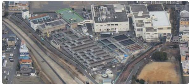
昭和9年に運転を開始した京都市で一番古い下水処理施設。伝統産業である染色工場が多いため、色度除去及び消毒を目的としたオゾン処理を導入し、放流先の西高瀬川に清澄な流れを回復しています。
