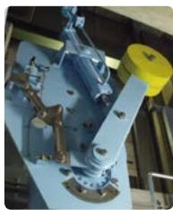
より配水管が破損した際に配水池から水道水が流出することを防ぎ、市民生活に最低限必要な飲料水を配水池に確保できます。
