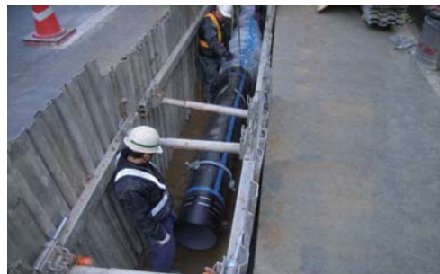
水道配水管更新工事
