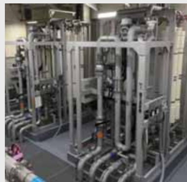
再整備事業により完成した大原第1浄水場膜ろ過設備
