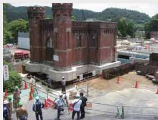
工事現場の様子
