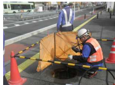
下水道管路の巡視・点検の様子
