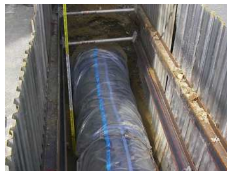
水道配水管の布設替工事
