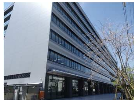
上下水道局総合庁舎
