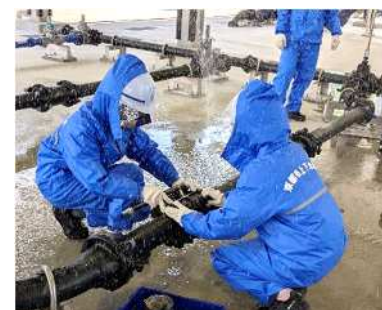
水道技術研修施設での研修 （水道管修繕材料技術研修の様子）
