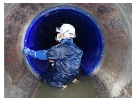
下水道管路の更生工事
