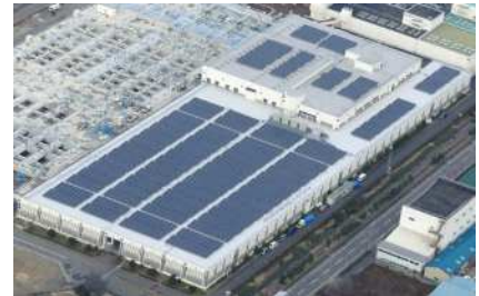
鳥羽水環境保全センターの 太陽光発電設備
