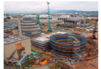
鳥羽水環境保全センター 汚泥消化タンクの再整備
