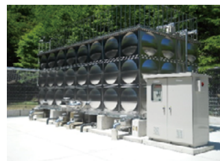
再整備事業により完成した余野配水池(細野地域水道)
