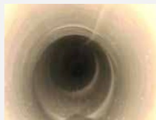
既設下水道管を使用した更生（長寿命化） （古くなった管の内側に新しい管となる素材を入れる）
