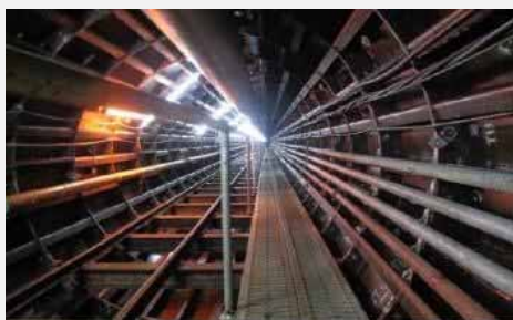
整備中の雨水幹線の内部（新川6号幹線）
