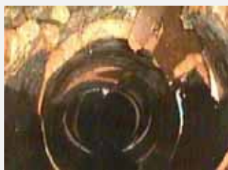
既設下水道管を使用した更生（長寿命化） （古くなった管の内側に新しい管となる素材を入れる）
