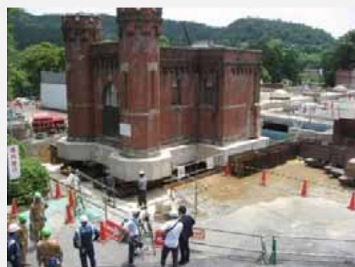
工事現場の様子
