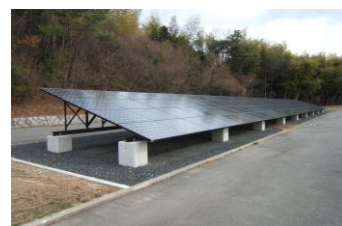
▲浄水場の太陽光発電設備
