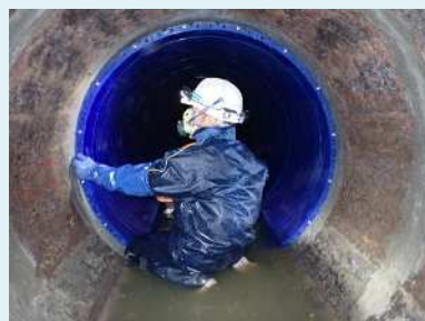
下水道管路の更生工事
