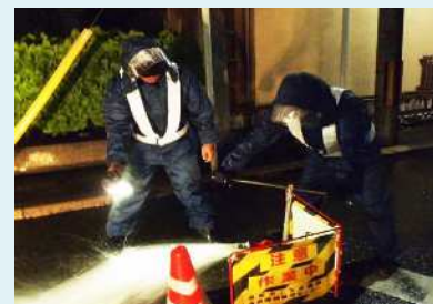
配水管の洗浄作業 (消火栓放水)
