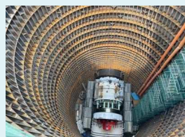
鳥羽第3導水きょ (発進立坑)
