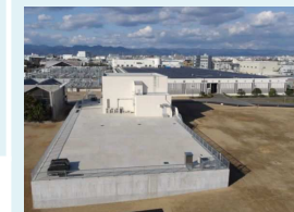
鳥羽水環境保全センター消毒施設 (塩素混和池)
