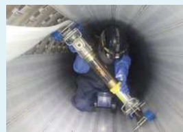
下水道管路の更生工事
