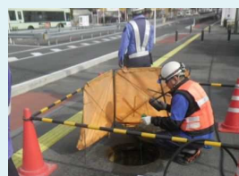
下水道管路の巡視・点検の様子
