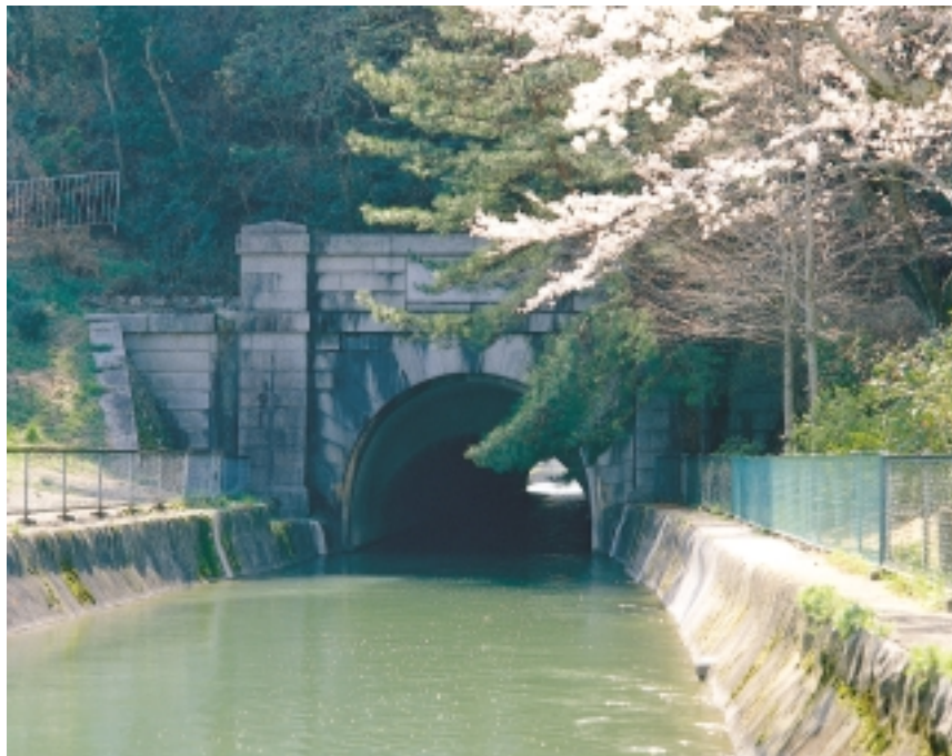
第1 疏水第2トンネル東口
