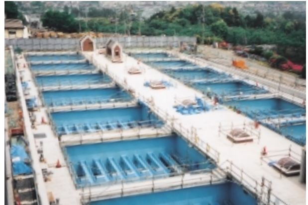
蹴上浄水場更新工事
