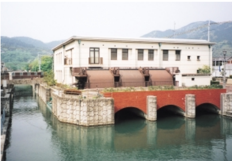
第1 疏水揚水機場
