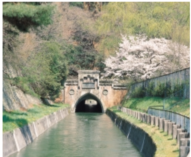
第2トンネル西口
