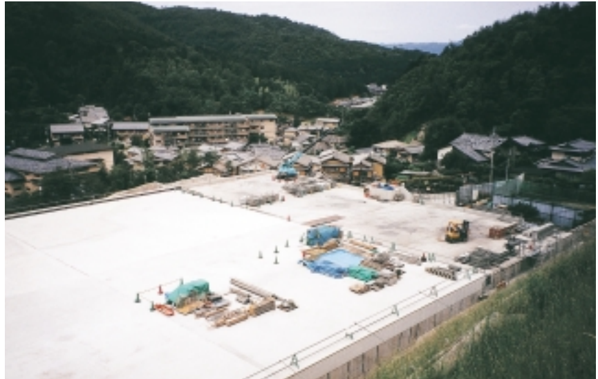
配水池築造工事
