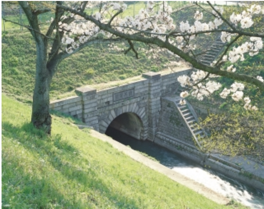
第1疏水第1トンネル西口
