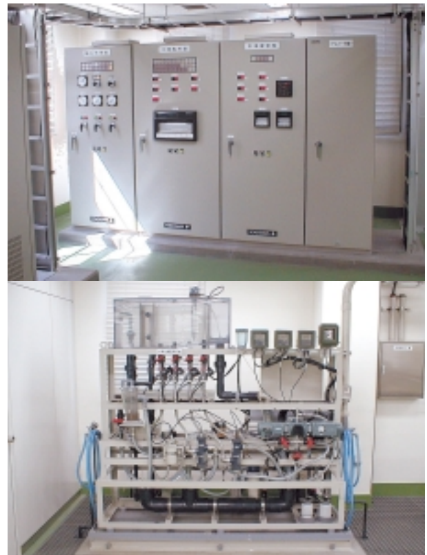
大津水質自動監視装置
