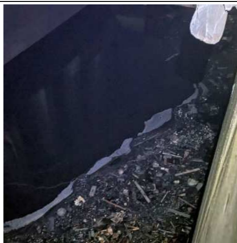
鎮火後の粗大ごみピット (水没した粗大ごみ)
