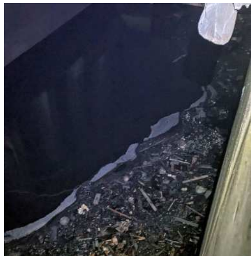
鎮火後の粗大ごみピット (水没した粗大ごみ)
