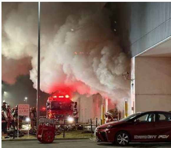
火災発生時の状況
