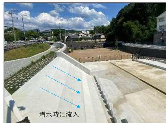
河川整備（七瀬川遊水地） （5か年加速化対策事業）
