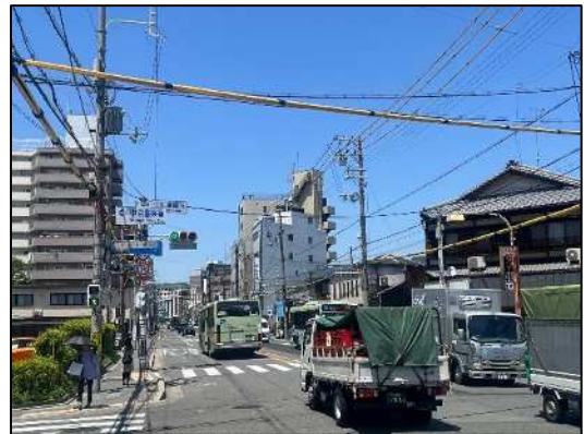
無電柱化事業（後院通）
