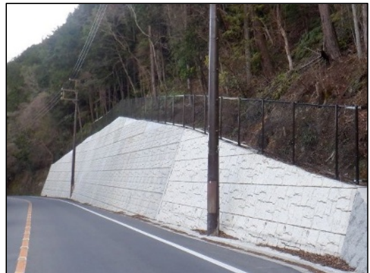
道路のり面对策（渋谷蹴上線） (緊急自然災害防止対策事業債を活用)
