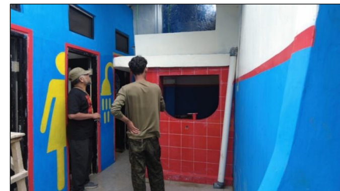
既存衛生施設の浄水状況確認作業の様子
