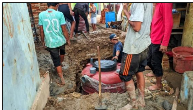
浄化槽設置作業の様子
