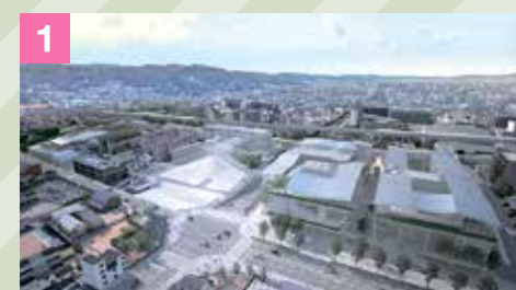
C地区北西側から
