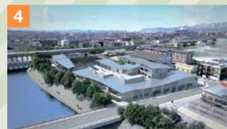
A地区北東側から
