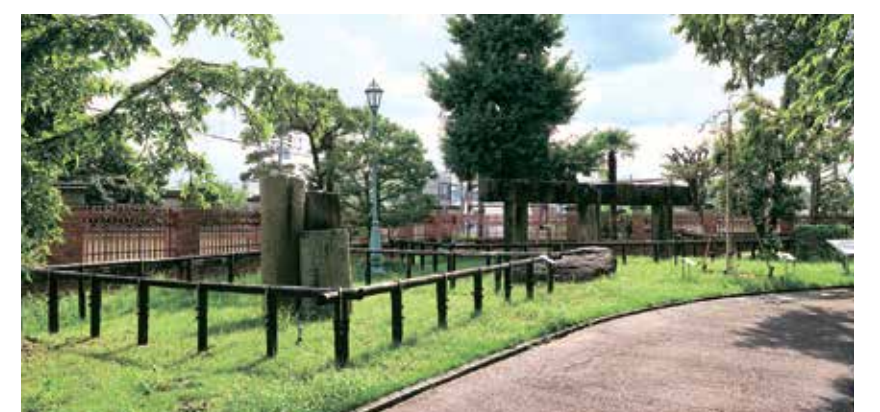
桃山時代につくられた五条大橋と三条大橋の橋脚。
